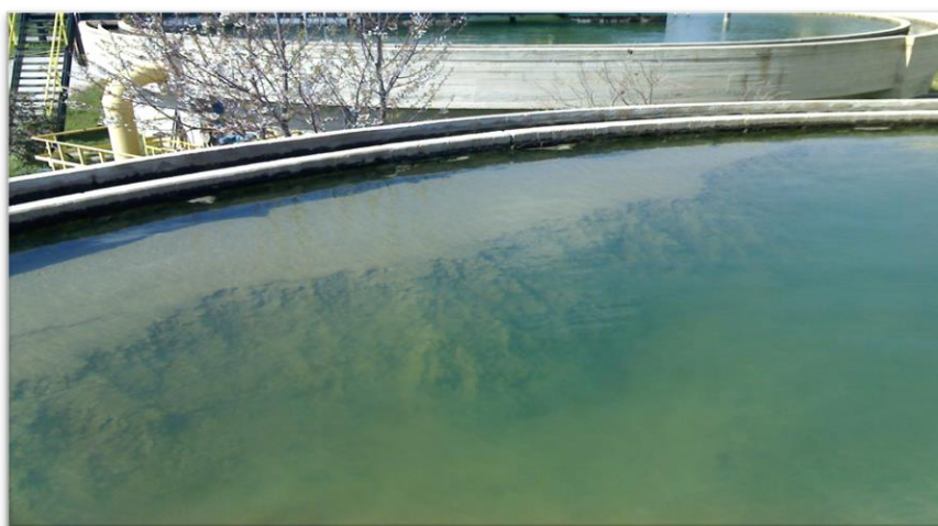
Fig. Evidente formazione di fango in eccesso
