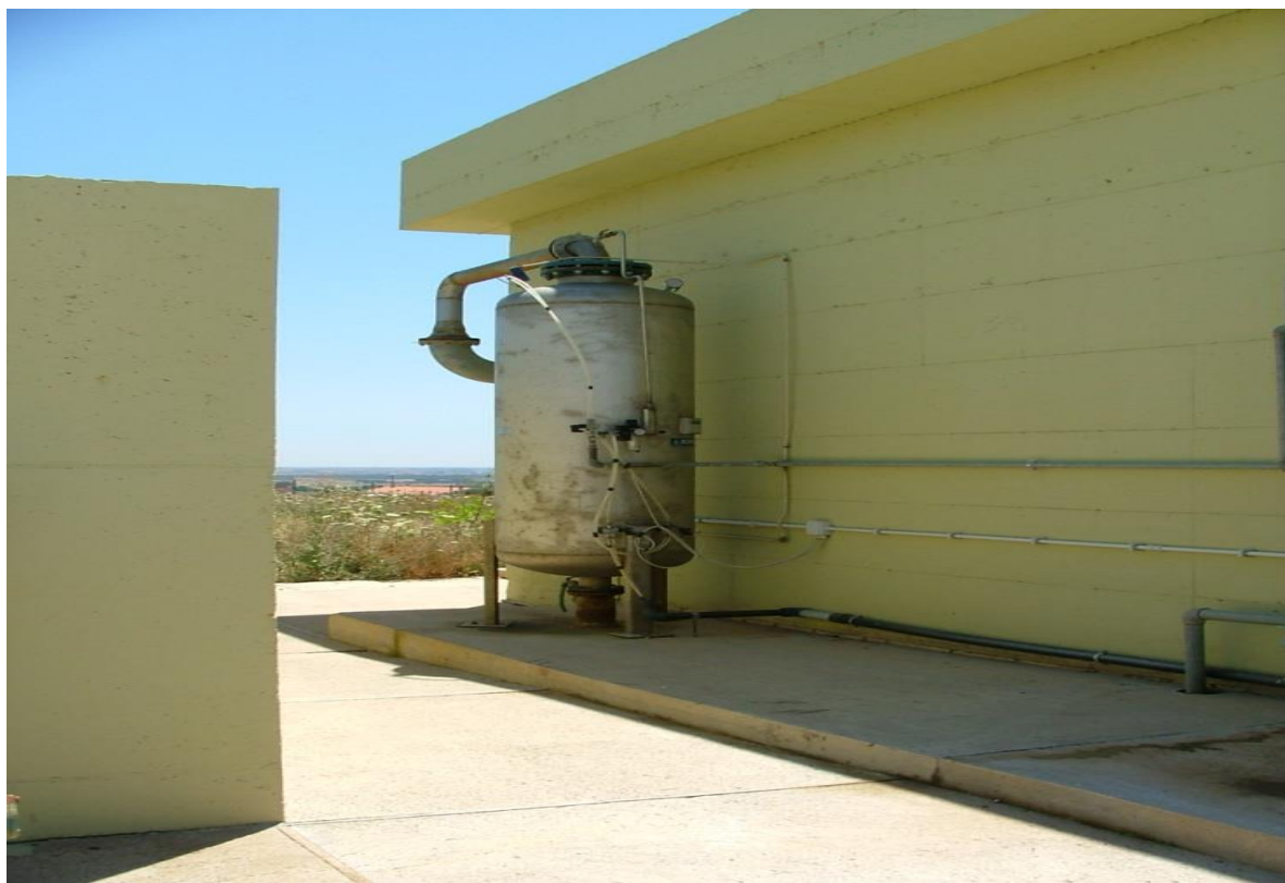
Fig. Esempio di sistema di pressurizzazione.
