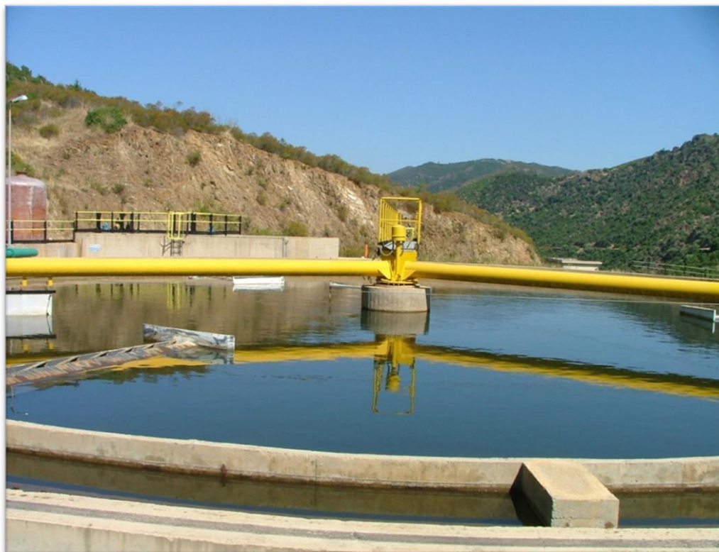
Fig. Flottatori in uso nell'impianto di Bau Pressiu.
